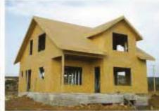
ESTRUCTURA DE MUROS EXTERIORES
